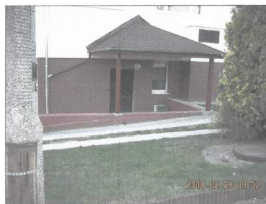
widok wiaty, front budynku
